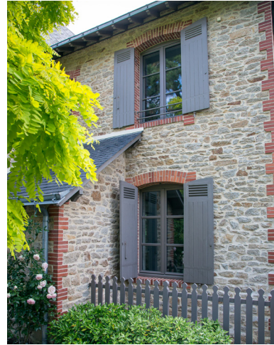
Finition des volets réalisée par le client
